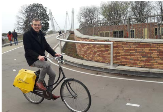
Dafne Schippersbrug, de fiets- en wandelbrug over het Amsterdam-Rijnkanaal
