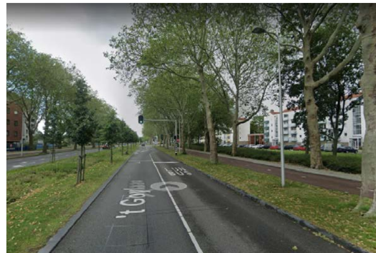
Sturen op autoverkeer bij toegang 't Goylaan
