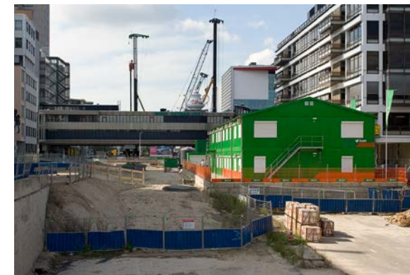
Bouwactiviteiten vragen om slimme logistieke oplossingen
