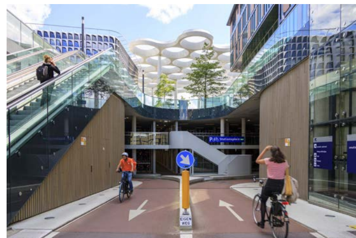
Fietsenstalling station Utrecht Centraal
