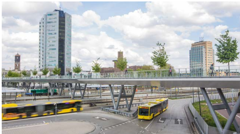
Moreelsebrug bij station Utrecht Centraal
