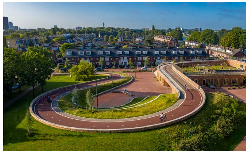
Op- en afrit naar Daphne Schippersbrug, zijde Oog in Al
